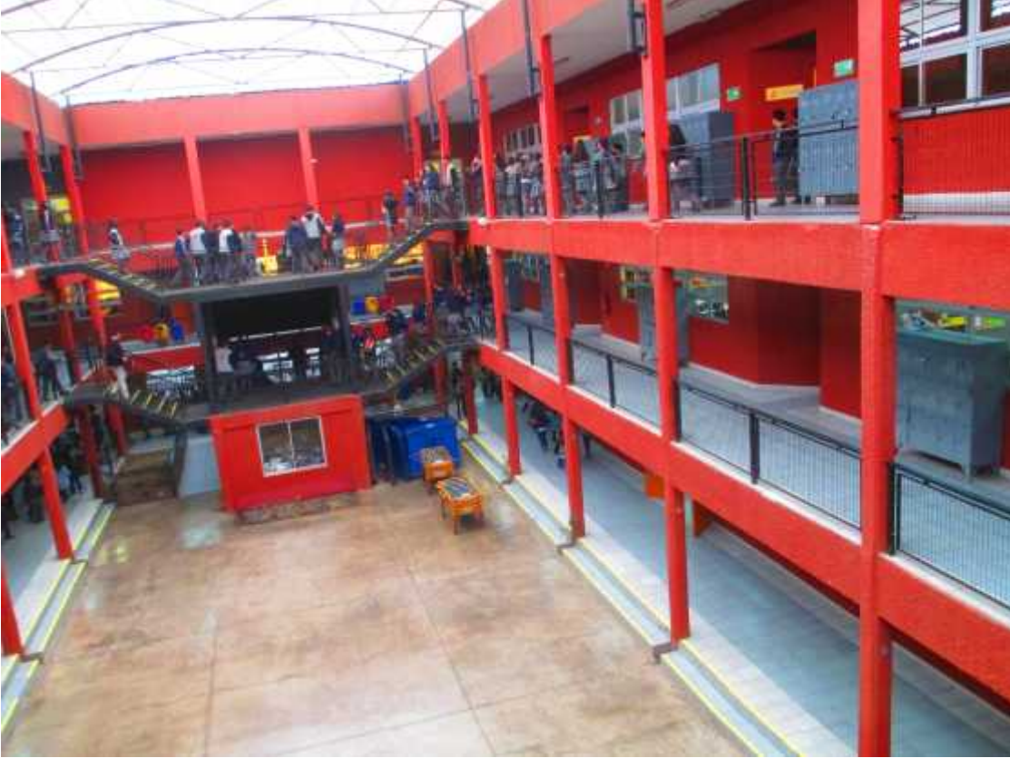
Evacuación zona norte del colegio
